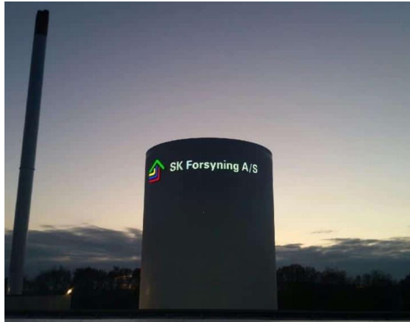
6.000 m 3 TTES in Slagelse (SK Varme) Source: Steeltank A/S
