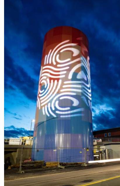
TTES in Detmold (Germany) – Stadtwerke Detmold, 1'850 m 3
